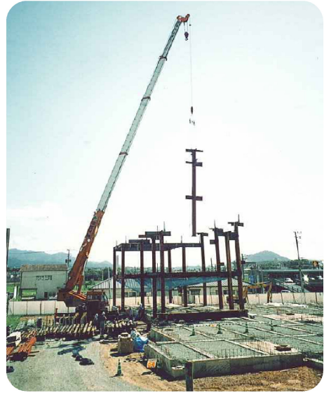
センター建設中
